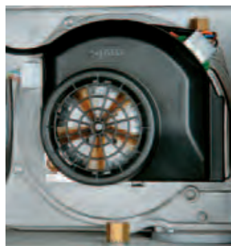
Постоянно контролируемое сгорание (модуляционный вентилятор)
